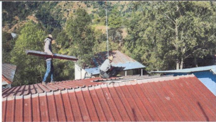
Foto 2: Sustitución de capote, para lámina troquelada aluzinc calibre 26 en módulo de aulas
