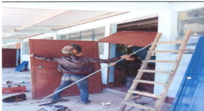
Foto 4: Fabricación e instalación de puertas de metal en módulo de aulas
