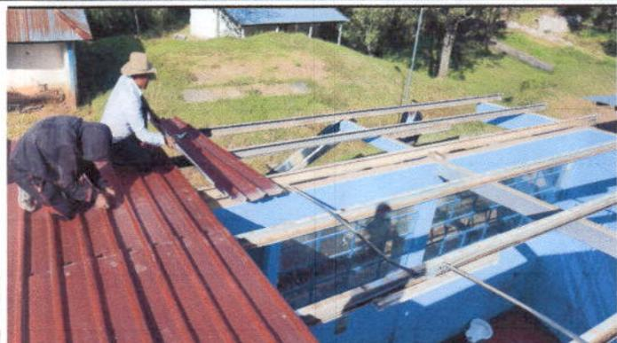
Foto1: Sustitución de lámina, por lámina troquelada aluzinc calibre 26 en módulos de aulas
